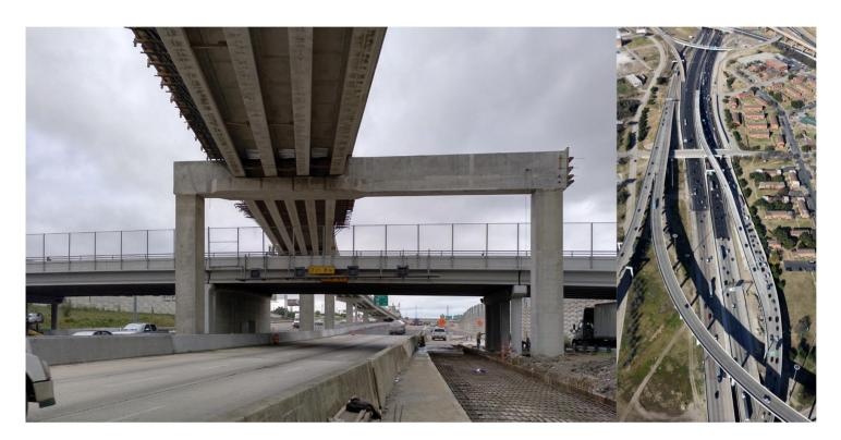
El conector directo IH-30 permite que el tráfico que se dirige hacia el este por la IH-30 se conecte con los carriles administrados de la IH-35 en dirección norte, cruzando los carriles de uso general y la calle Luella. Es un puente de 18 vanos con un diseño en forma de S. El diseño implicó la ampliación de una estructura existente y el diseño de una variedad de tipologías de pilares.
